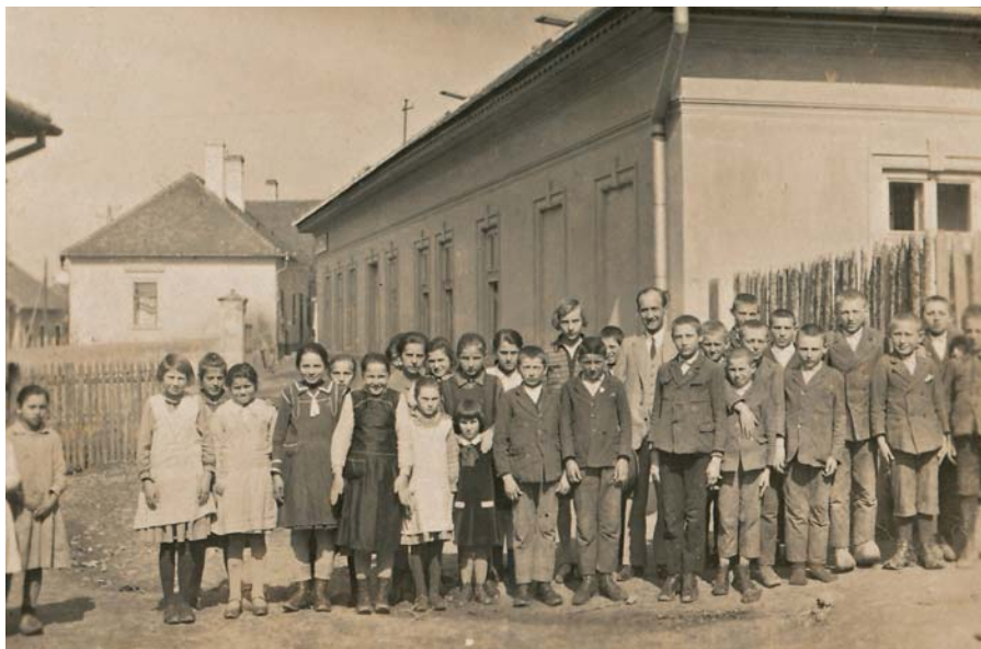
riaditeľ O. Markovič s deťmi pred budovou starej školy - v pozadí fara
