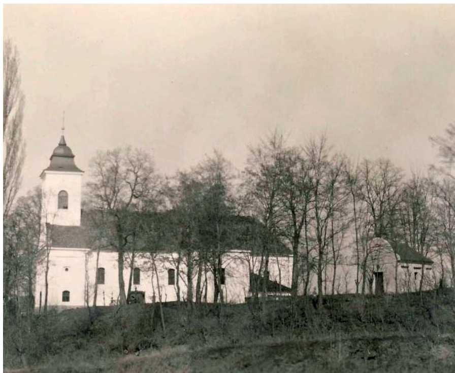
kostol s kaplnkou Ondreja Barana
